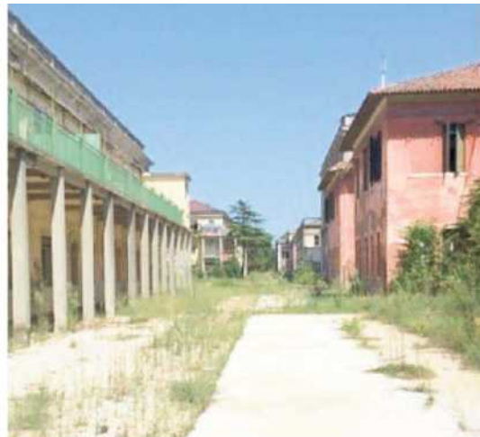
Il grave degrado in cui versa la struttura
