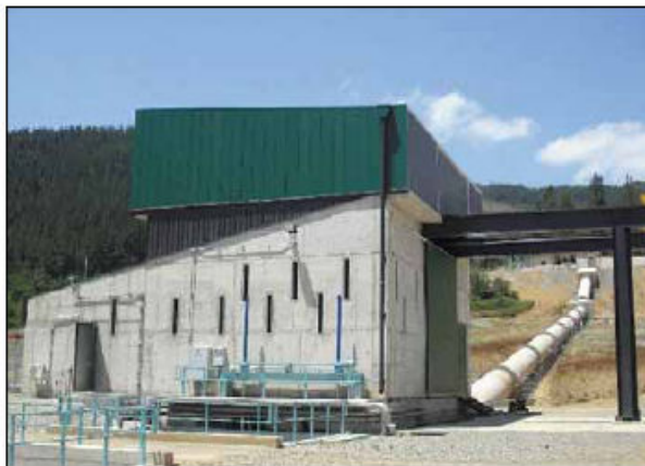
CILE La nuova centrale idroelettrica di Sorgent.e
